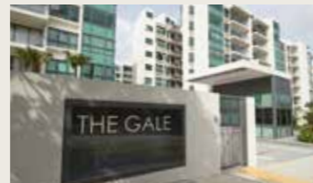
The Gale • Flora Road • 329 Units • TOP: 3 Jan 2013
